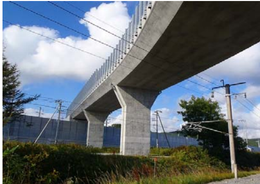
写真4 完成状況 (A-2橋台側より)
