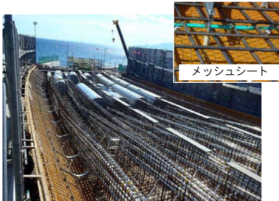
写真3 主桁の施工状況
