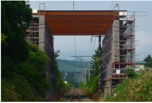
写真2 JR防護工の施工状況
