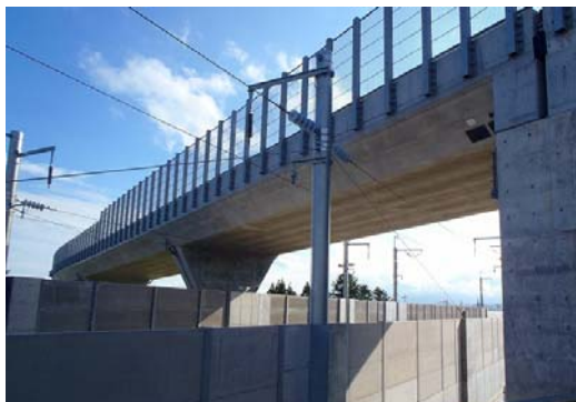
写真5 完成状況 (A-1橋台側より)
