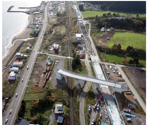
写真6 完成状況 (空撮)
