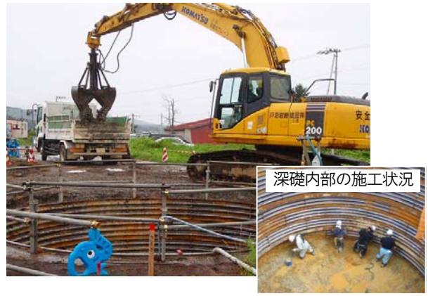
写真-1 深礎杭の施工状況
