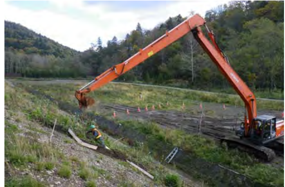
写真-8 表土ブロック定置状況
