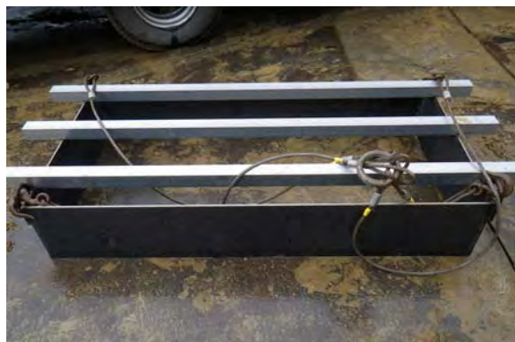
写真-1 根切り用鋼製枠
