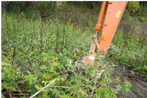
写真-4 鋼製枠による根切り状況
