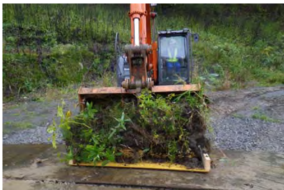
写真-6 運搬・定置型枠への積み替え状況
