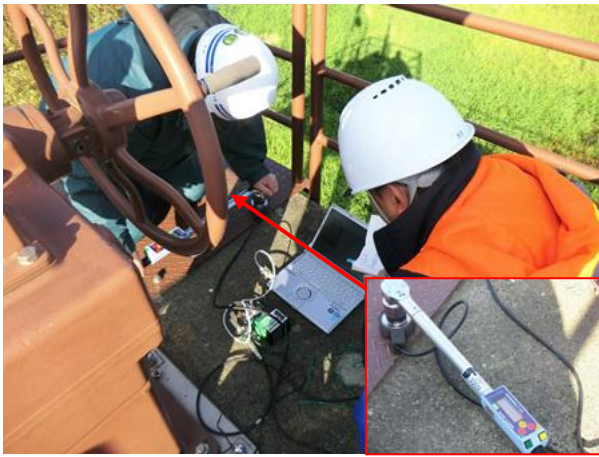
写真-4 トルク・引抜き強さ確認試験状況 (A 樋門)
