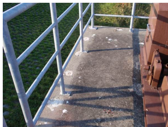
写真-3 B樋門の状況
