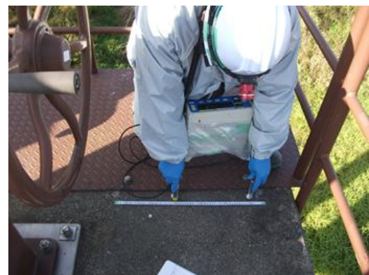
写真-5 表面走査法による調査状況 (A 樋門)
