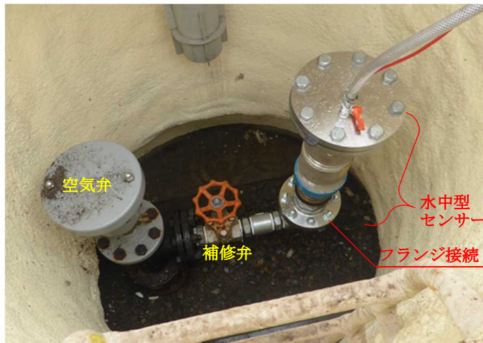
図-4 水中型センサー取付例
