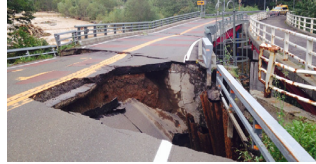
写-3 KP=33.4奥漁川橋
