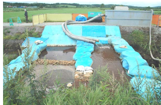
写真3 排水路工事における汚濁処理施設
