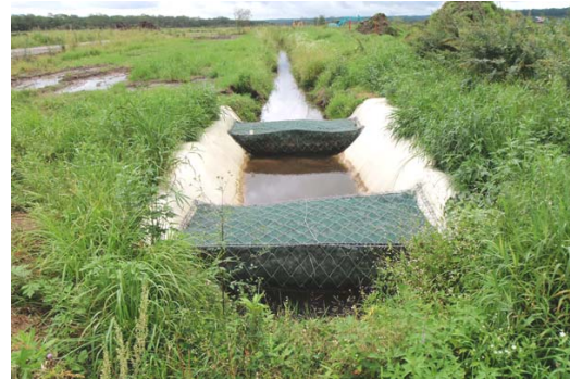
写真2 農地保全工事における汚濁処理施設
