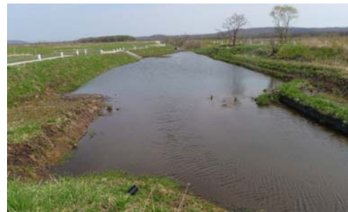
写真1 排水路下流部の沈砂池
