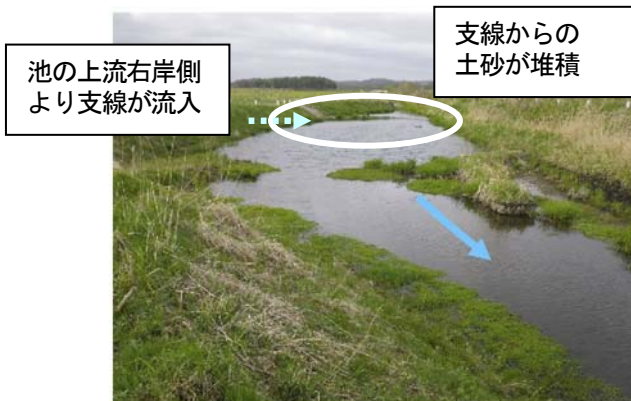
写真4 幌呂1号排水路 支線から沈砂池への流入状況
