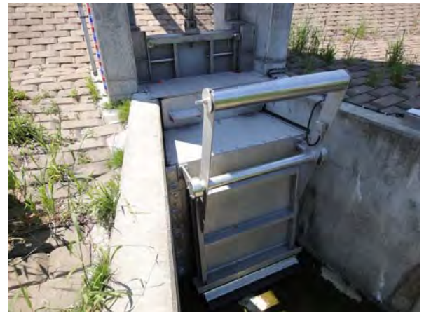
図-5 予備ゲート設置状況写真
