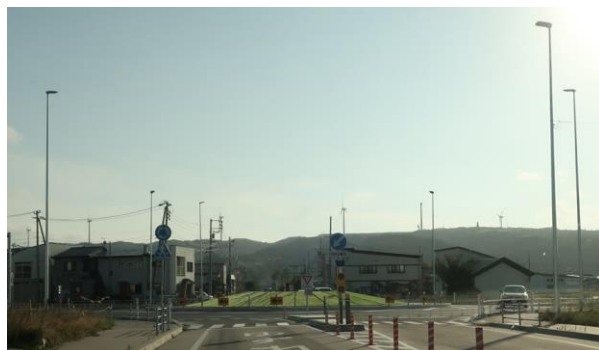
図-14 中央島のマウンドを高くすることにより対面見通しを無くした例(北海道上ノ国町)
