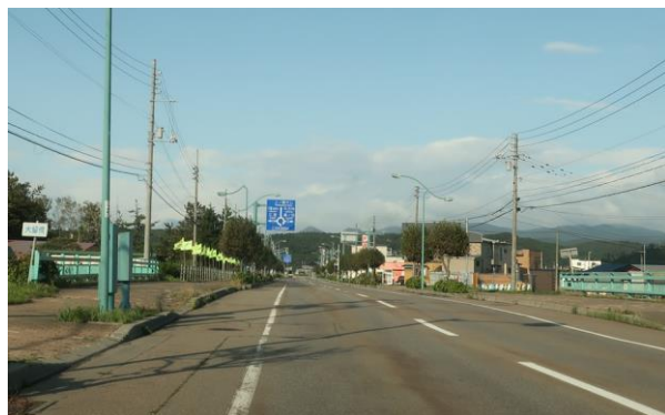
図-15 ラウンドアバウトの手前に道路標識(写真中央)を置いて運転者に認知させる例(北海道上ノ国町)
