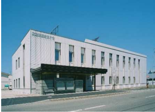
図-6 A庁舎外観
