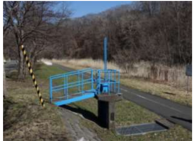
写真1 千歳川に設置されている樋門
