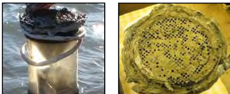
写真-1 目詰まり発生状況
