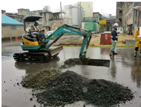
写真-6 焼却灰を用いた試験施工箇所における開削調査
