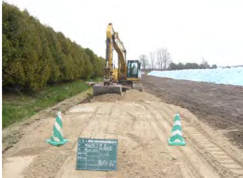
写真-4 工事用道路設置状況
