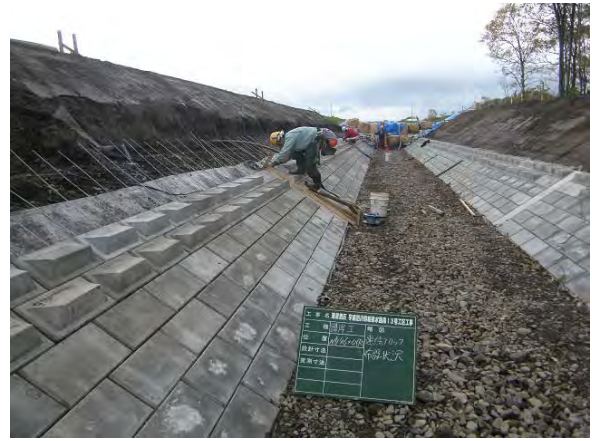
写真-11 階段式連節ブロック
