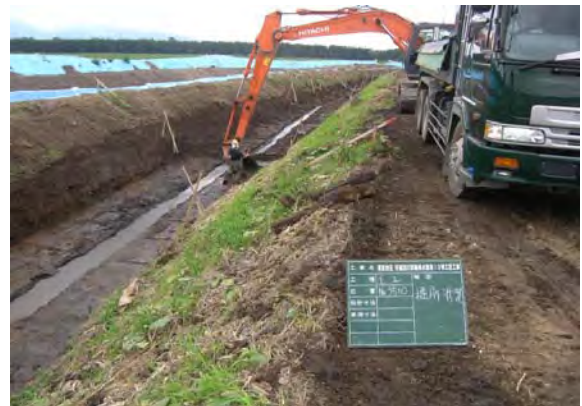
写真-7 河床掘削状況
