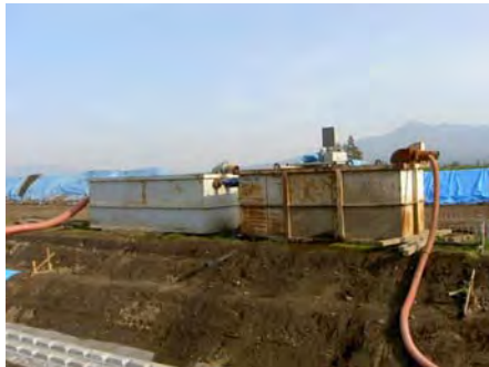
写真-13 汚濁防止用鋼製水槽
