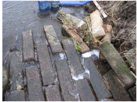
写真-6 既設連節ブロック
