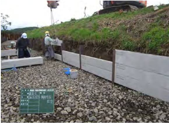
写真-8 コンクリート柵板設置状況
