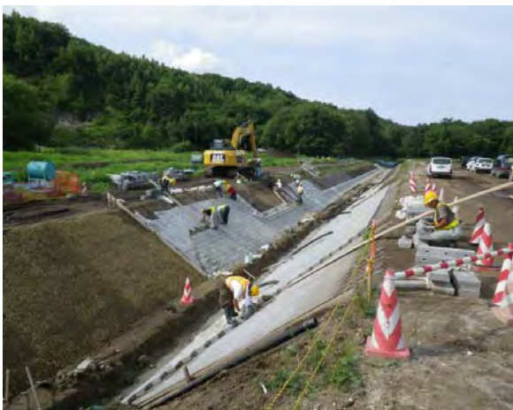
写真-9 連節ブロック設置状況
