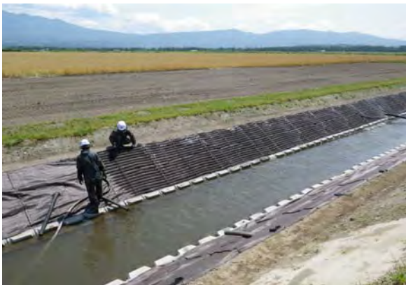
写真-10 植生マット施工状況
