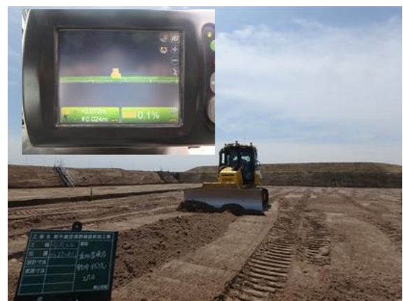
写真4 ICT建設機械施工状況 (上から法面整形状況、敷均し状況)
