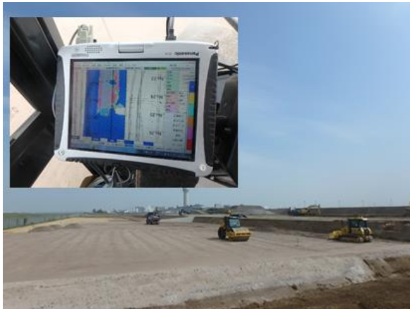
写真-5 振動ローラーによる転圧状況
