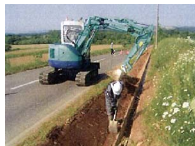
写真－1 バックホウによる施工
