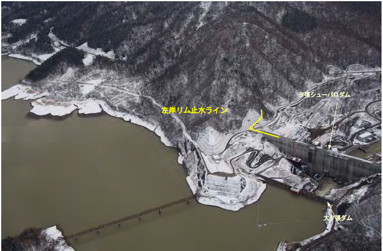
写真4 夕張シューパロダムと左岸リム部
