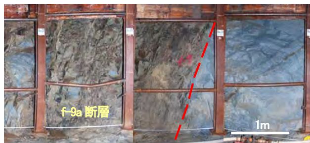
写真-3 左岸リムトンネルに出現したf-9a断層
