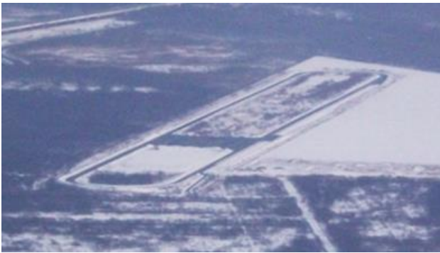
写真-1 苫小牧寒地試験道路
