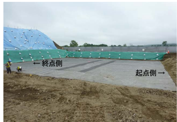
写真-1 カルバート基礎補強工の施工状況 (No. 2 ボックスカルバート: 2016. 7. 27 撮影)
