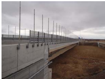
写真-3 防鳥ポール設置例（釧路新道）
