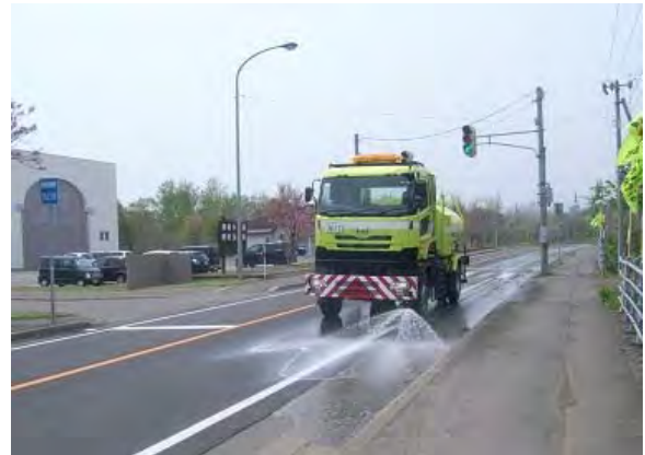
写真-10 散水作業状況
