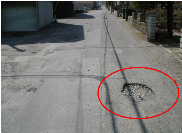
図-8 事例写真(例)
