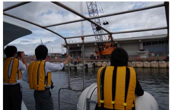
【図5 海上から稚内港岸壁改良工事を見学】
