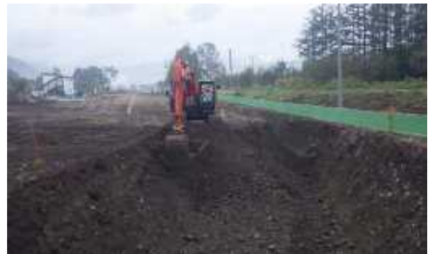
写真-2 MG技術（バックホウ）の施工状況
