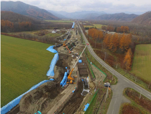
写真-1 札内川導水路の施工状況
