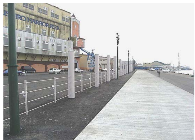
写真-1 津波漂流物対策施設（釧路港）
