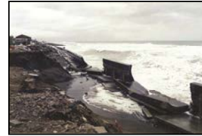
写真7 越波による直立護岸の被災、通行止め
