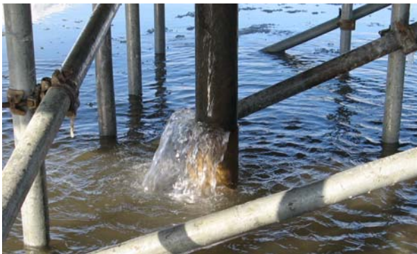
写真-1 B-2における地下水自噴状況
