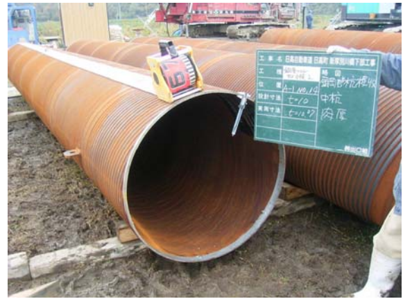
写真－2 リブ付鋼管杭
