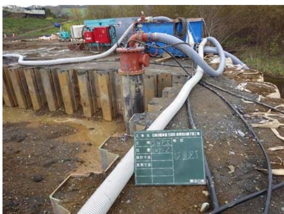
写真－6 設置完了
