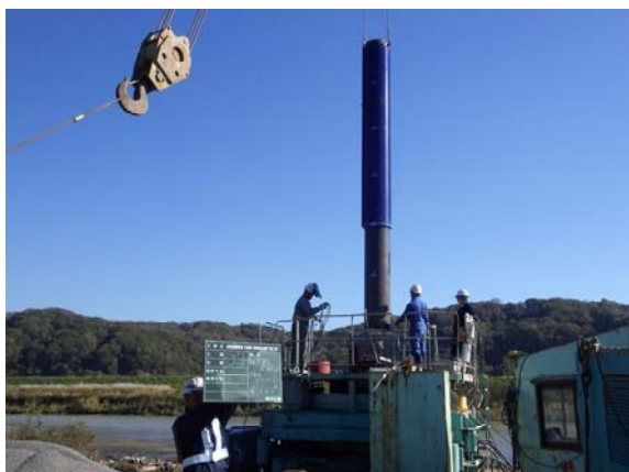
写真－4 スクリーン・鋼管建込状況
