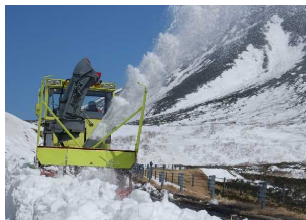
写真-3 ブロウからの投雪状況
