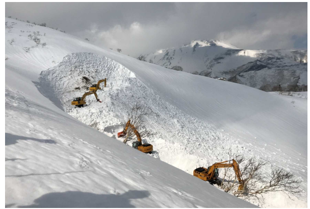
写真-1 バックホウによる道路部および斜面部の除雪
