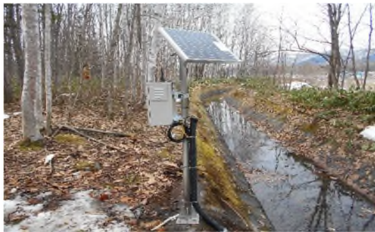
写真-2 Web水位監視システム設置状況
