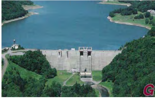
図-2 鹿ノ子ダム全景
