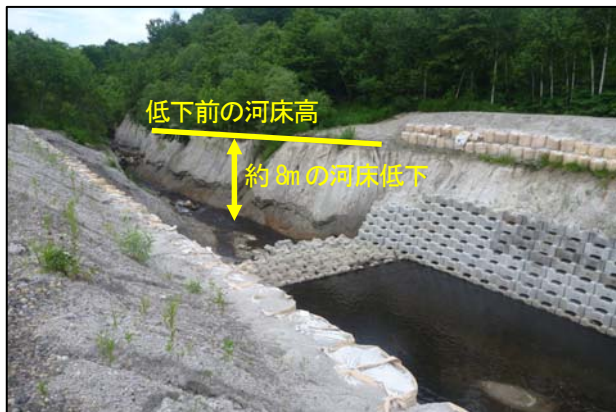
写真1 渋山川の河床低下状況
