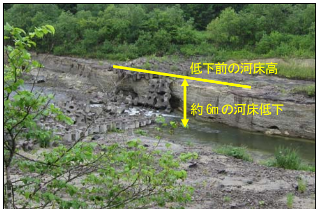
写真2 然別川の河床低下状況
