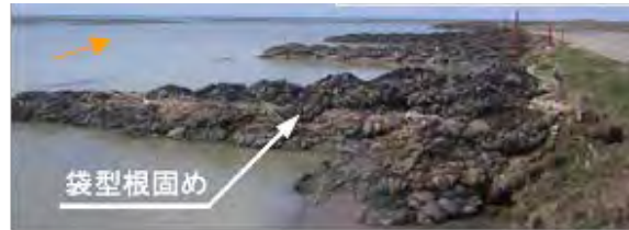
写真2 右岸水制工の設置状況
