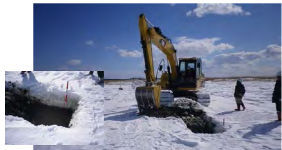
写真3 滯筋の冬季施工試験
