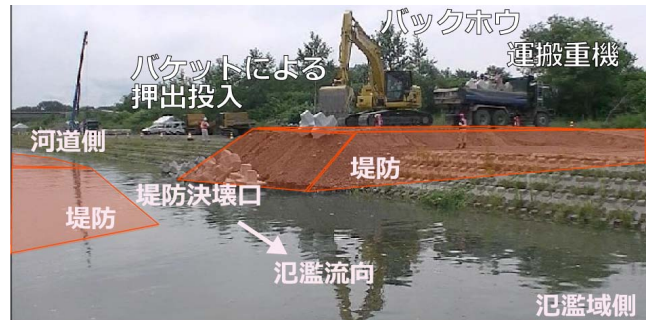
重機による効率的な資材投入検証
