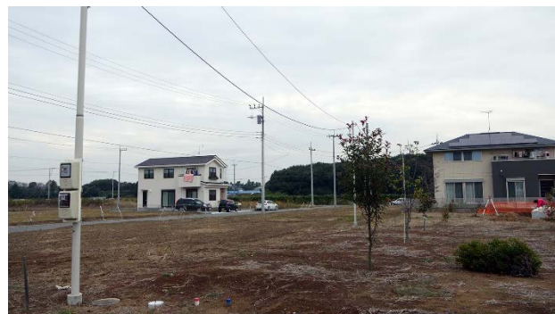
写真-2 宅地開発で新たに建てられる電柱類
