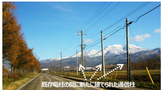
写真-1 近年増加している通信線と通信柱
