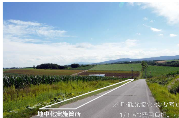
写真-3 農村・自然域における無電柱化の実施事例
