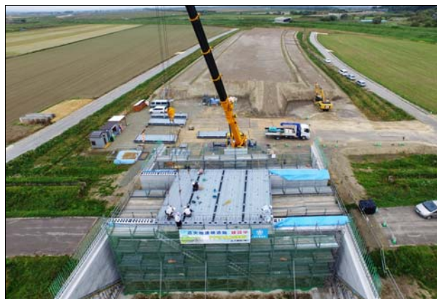
写真-3 土木工事での活用例(北土建設㈱提供)
