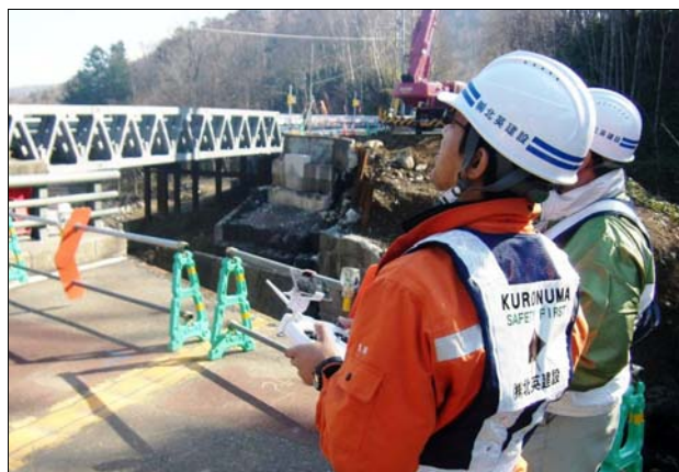
写真-4 ドローンオペレータ(㈱北英建設提供)
