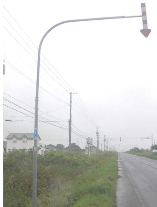
写真-1 測定対象の固定式視線誘導柱とベース固定ナット
