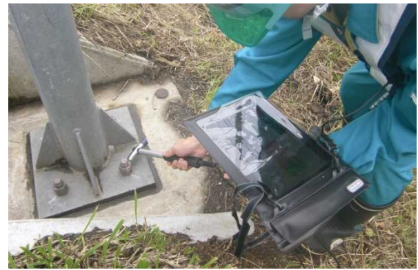
写真-2 ナットの測定状況
