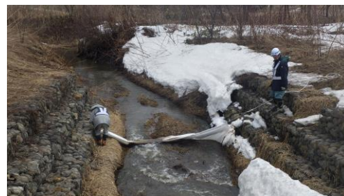
写真-9 発生源近くに設置したオイルフェンス
