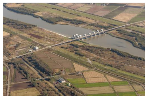
写真-1 石狩川頭首工と篠津運河
