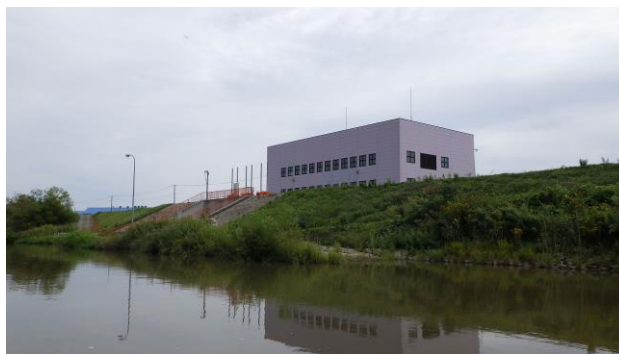
写真-17 船上からの美原揚水機場
