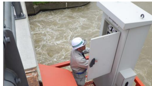
写真-8 32線調節水門の操作
