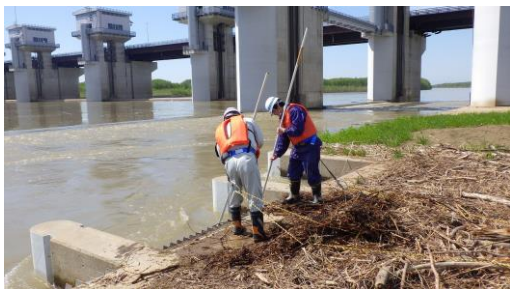
写真2 取水口の流木等除去作業
