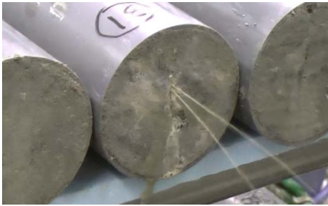
写真6 排出口の中心部付近から排出している状況例
