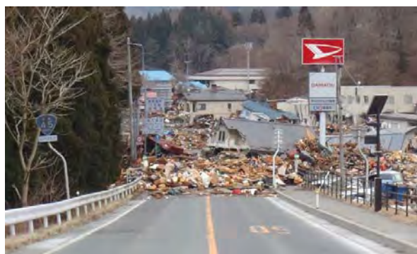
写真-1 津波襲来後の一般国道45号(岩手県宮古市)
