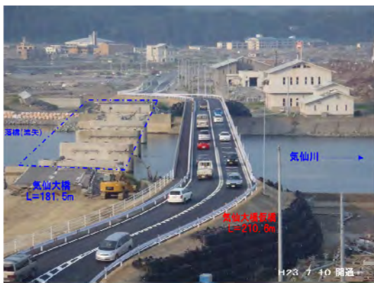
写真-2 4ヵ月後に復旧した気仙大橋(岩手県陸前高田市)
