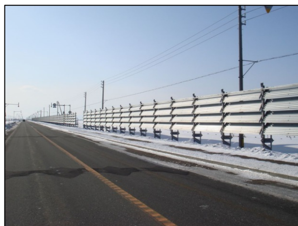
写真-1 吹き払い柵
