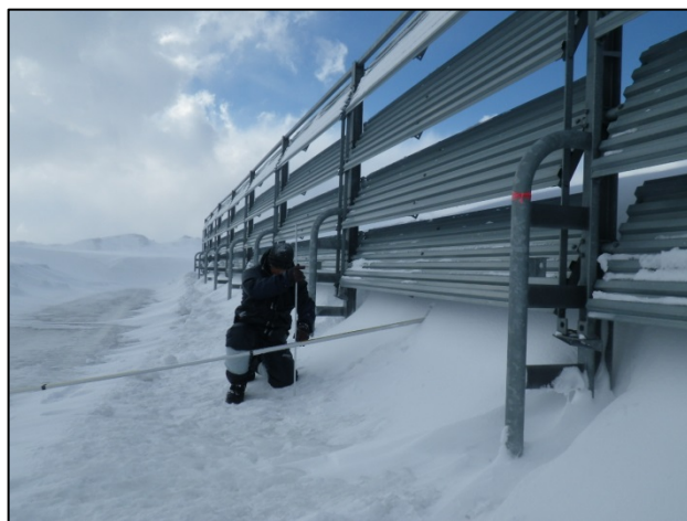
写真-3 下部間隙付近の積雪深の計測
