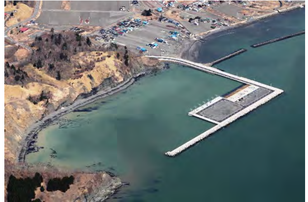
写真-1 平成23年度に完成した門静地区副港
