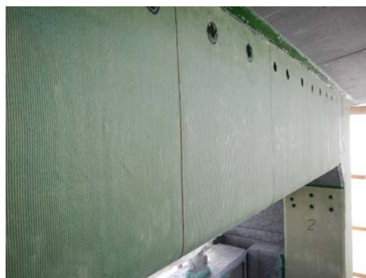
写真-3 アラミド繊維シートによる門柱・操作台補強
