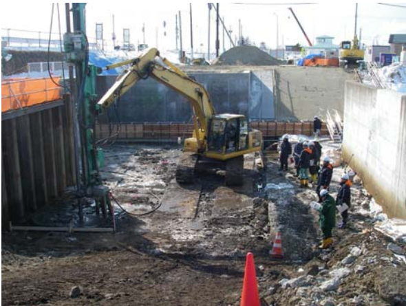
写真-5 MITS 工法による地盤改良
