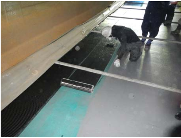
写真-4 炭素繊維シートによる函体補強
