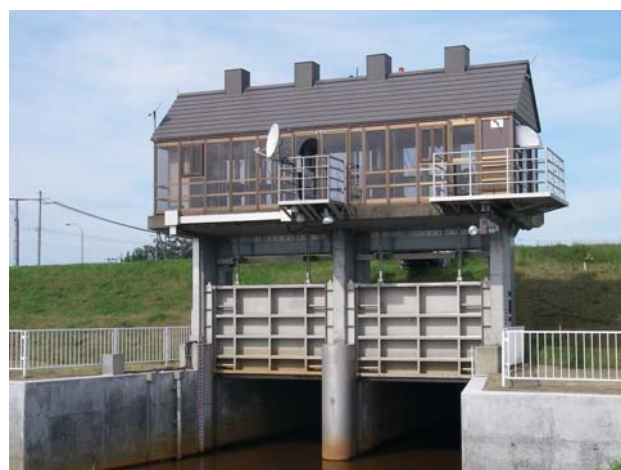
写真-2 昭和樋門
