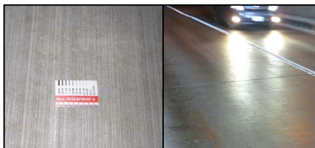
写真-1 左：施工直後のCo舗装のほうき目仕上げ 右：供用に伴い光沢を帯びたCo舗装路面
