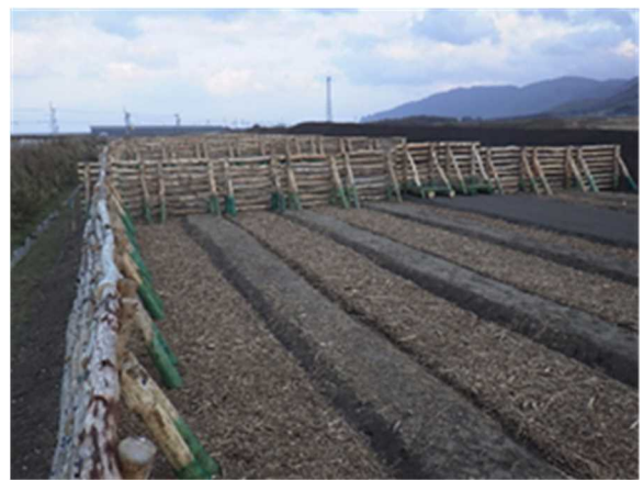
写真-1 間引材材防風柵の設置状況
