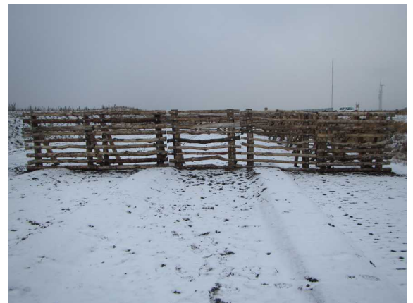
写真-2 間引材防風柵(空隙率調整)の設置状況
