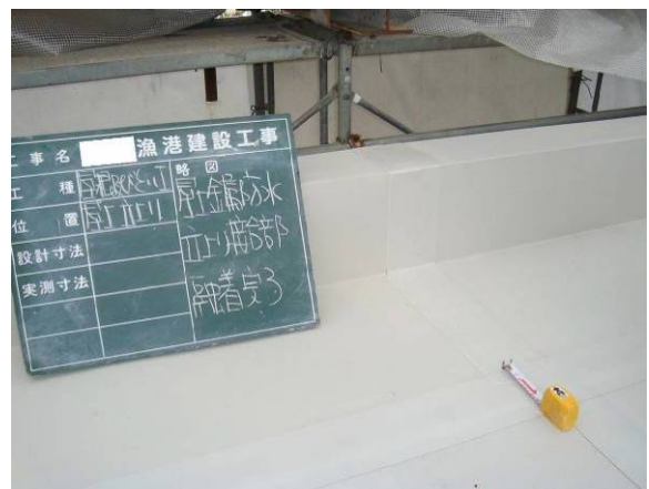
写真-5 鋼板熱風融着防水
