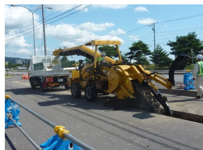
写真-1 トレンチャーの現道掘削実験状況
