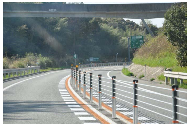
写真-2 浜田自動車道（暫定2車線区間）に設置されたワイヤロープ（島根県浜田市）
