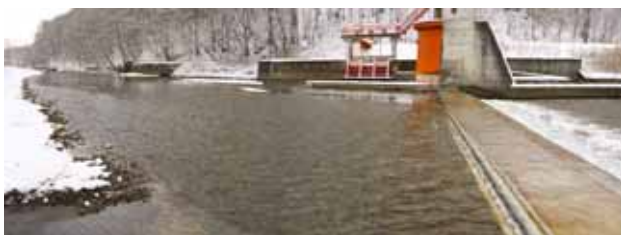
写真-2 非取水時のみお筋
