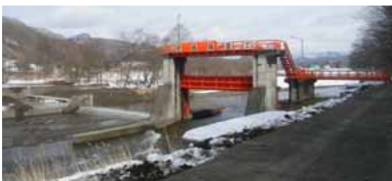
写真-4 塗装後のゲート
