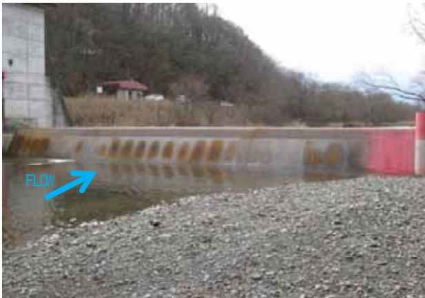
写真-1 洪水吐ゲート 扉体上流面
