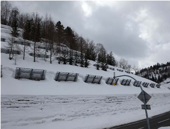
図-1 観測箇所(一般国道275号幌加内町朱鞠内湖畔)
