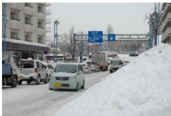
写真-1 道路有効幅員の減少
