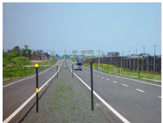
写真-6 視線誘導標
