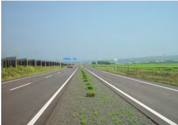
写真-7 幅広中央分離帯
