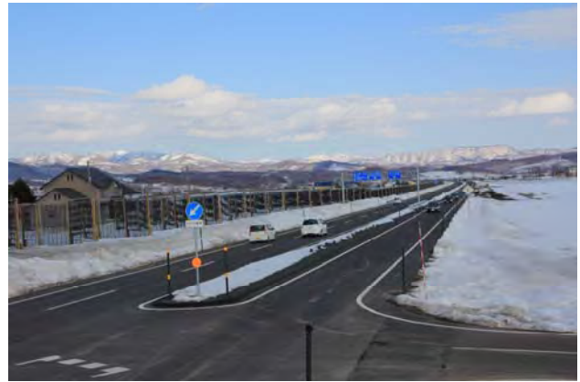
写真-8 ゆずり車線(2+1車線)
